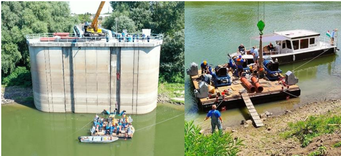
1. és 2. fénykép Provizorium kiépítése a Szolnoki Felsővízi Vízkivételi Műnél
